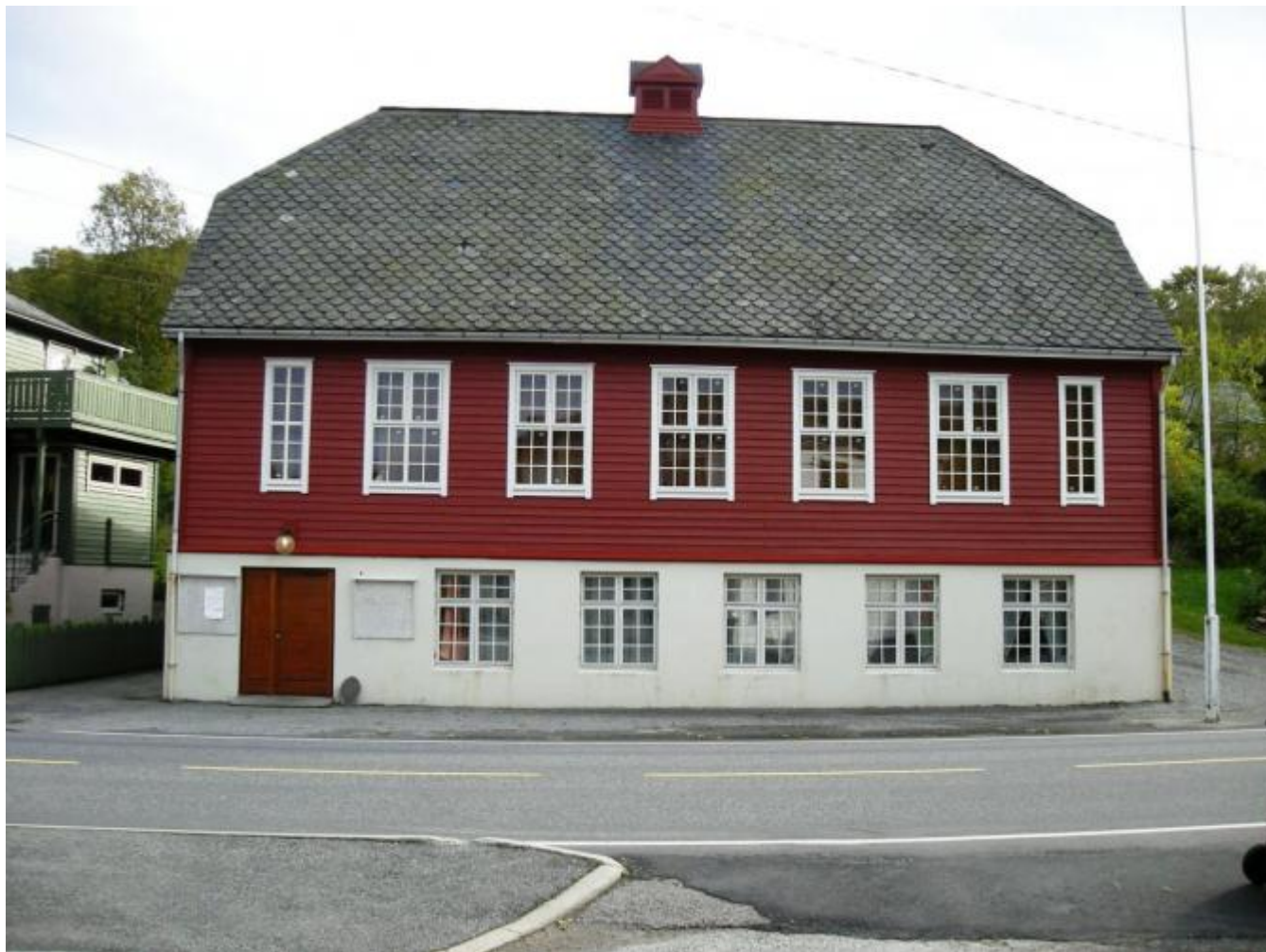
Rømningsvegane frå Helgheim er ikkje tilferdsstillande. (Foto: Ola Matti Mathisen)
