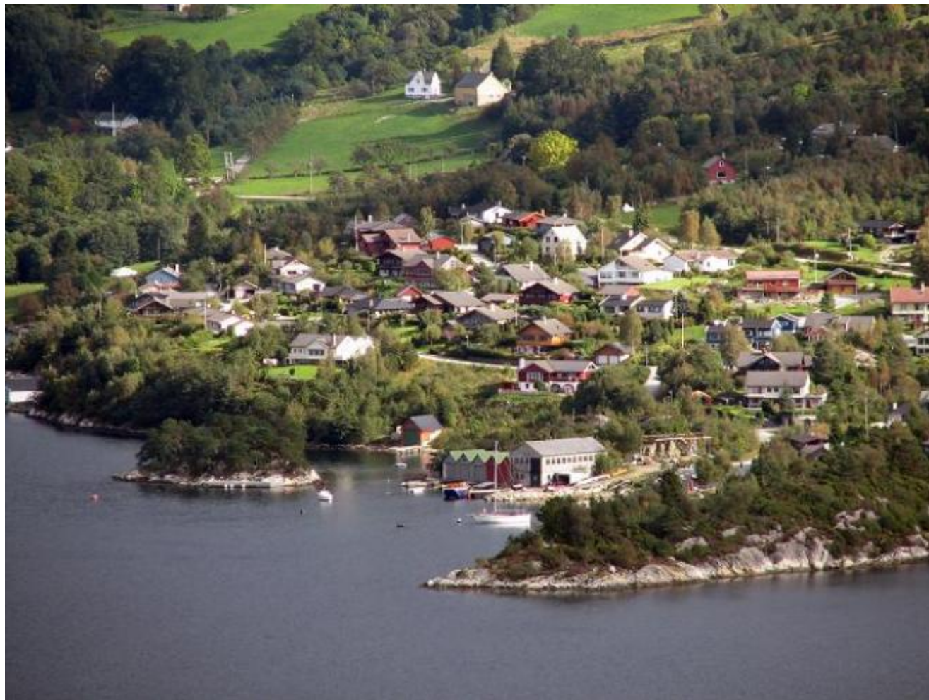
Korsnes får eitt avløpsanlegg
