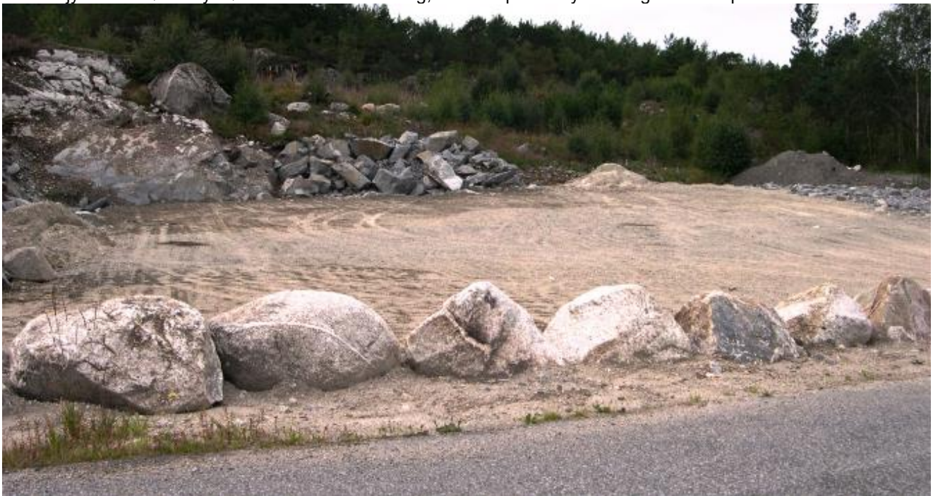
Prosjekt på gang på Børnes: Tilretteleggjing av tomt for Rune Hjørnevåg.
