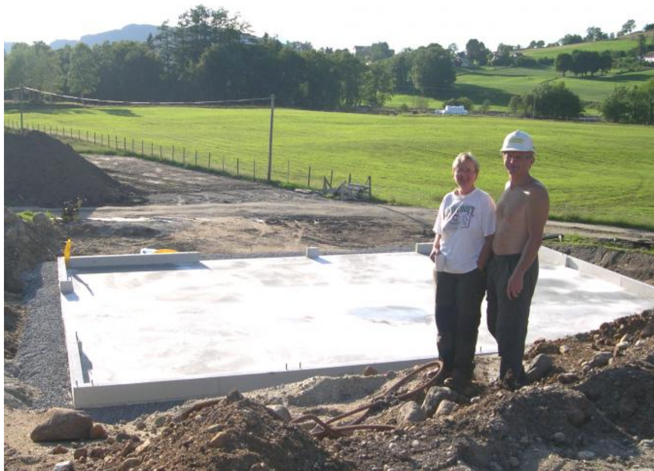
Ivar Kåre og Berit Harriet Døssland ved plattingen der stålhallen skal reisast. (Foto: Ola Matti Mathisen)
