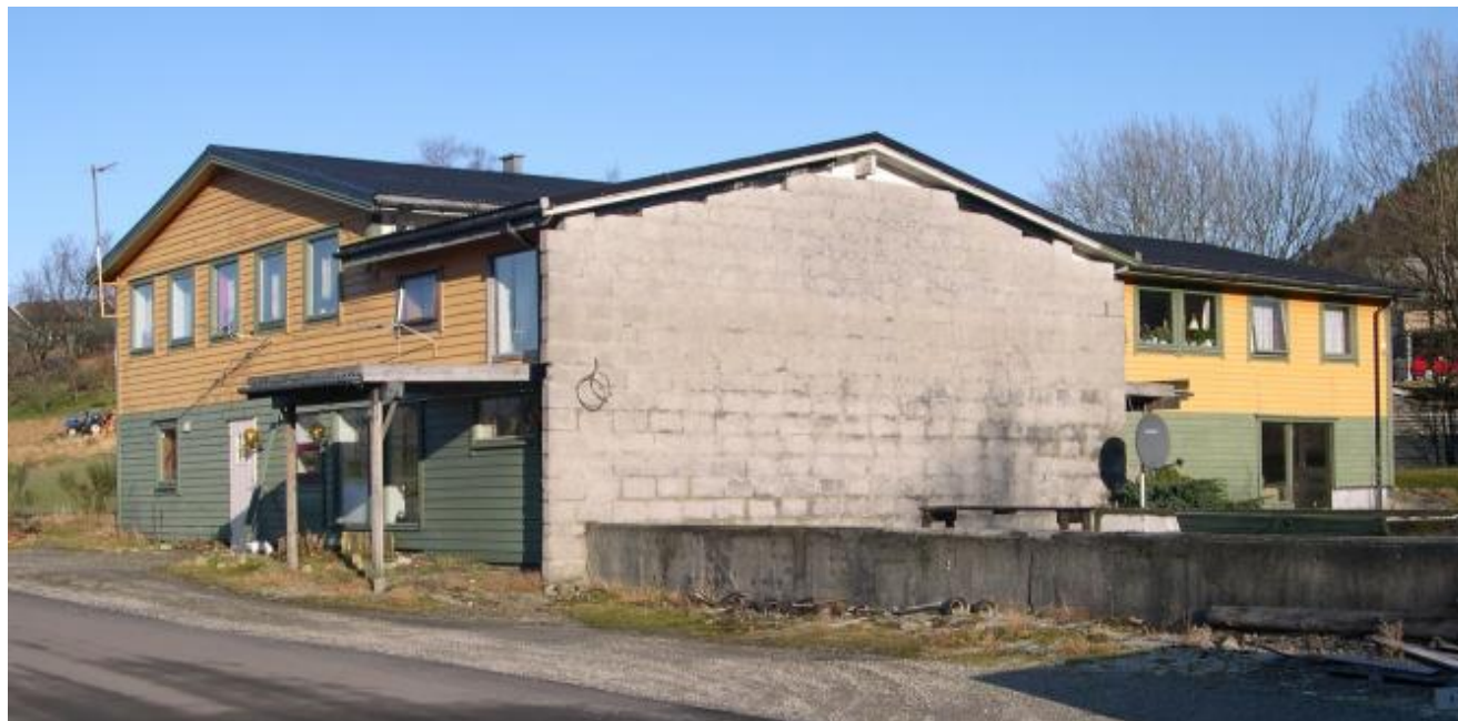
Første byggjesteget omfattar rehabilitering og innreiing av tre nye bueningar i dette huset. (Foto: Ola Matti Mathisen)
