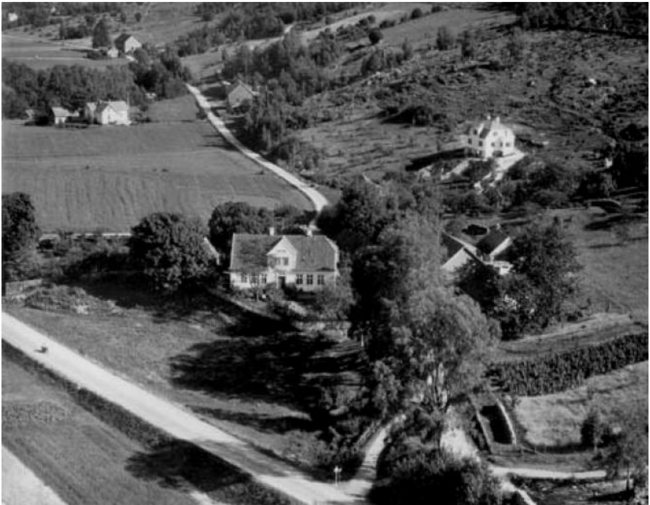
Nedre Feet bør framleis vera den offisielle postadressen, meiner oppsittarane. Namnet er ein del av Uskedalen si historie og identitet. Dette er eit flyfoto av området, truleg teke for rundt 50 år sidan
