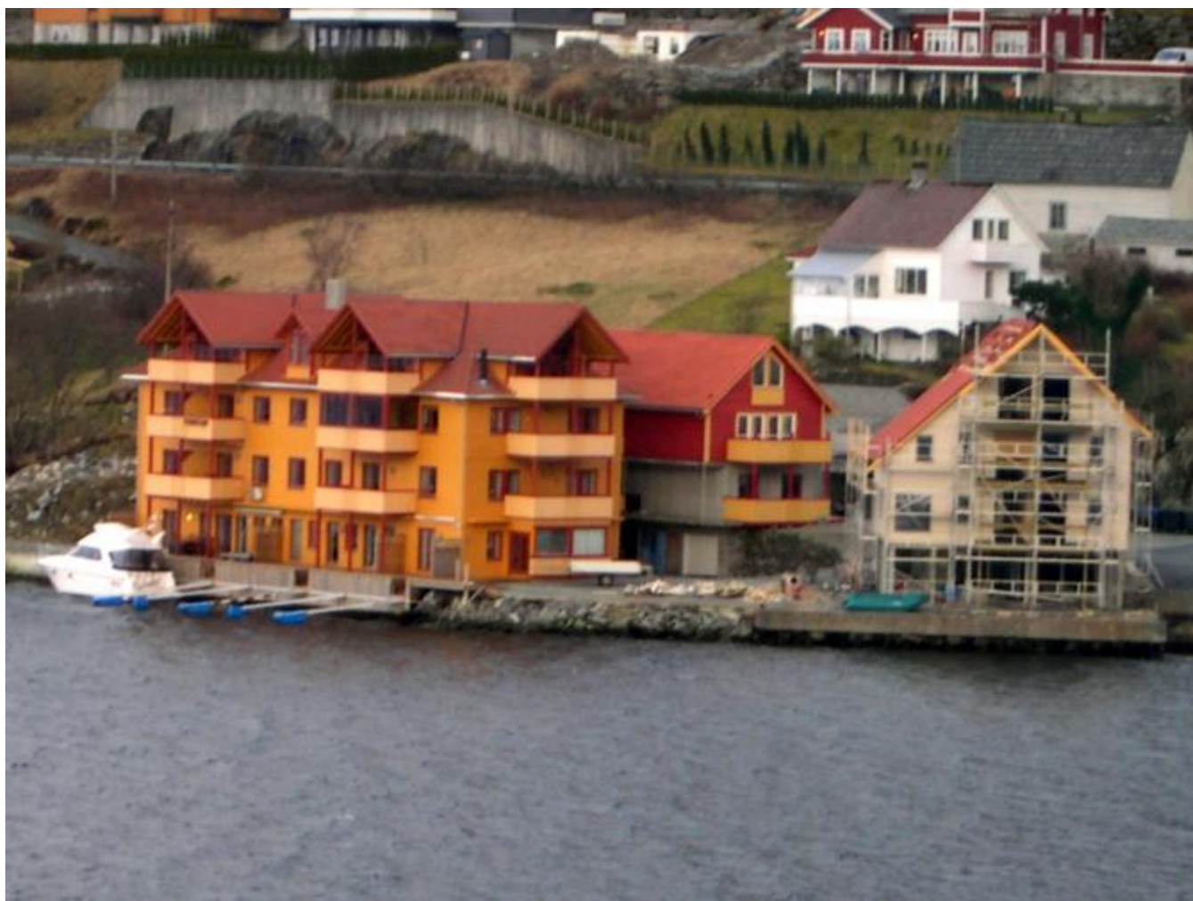
To nye seksjonar i Uskedalen Brygge har no fått midlertidig bruksløyve.. Arbeidet med sjøhuset går også raskt framover. (Foto: Ola Matti Mathisen)
