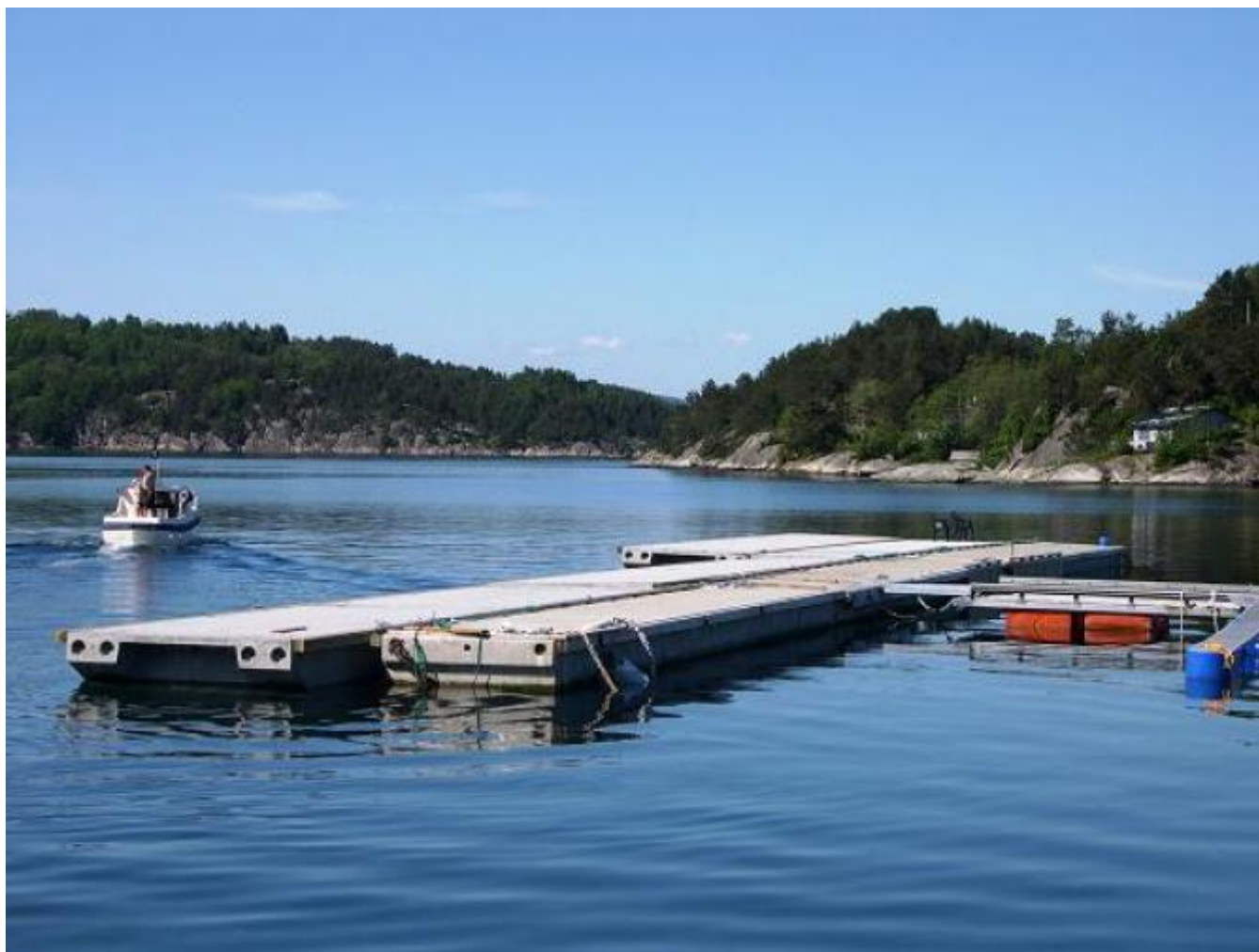
Betong-elementa frå Ørsta Industri har kome til Uskedalen ein av dei første dagane i juni og er klare for montering. (Foto: Ola Matti Mathisen)
