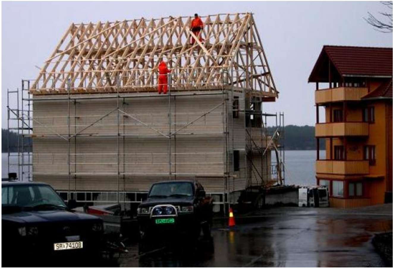
Det skal bli fem leilegheiter i huset som no er under byggjing i Beinavikjo. (Foto: Ola Matti Mathisen)
