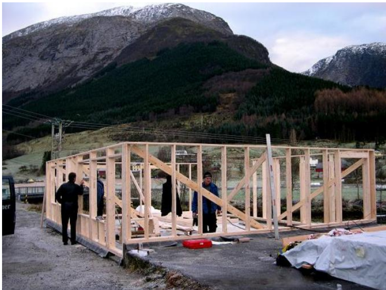
Eit nytt bygg reiser seg på gamal kjellar mellom det tidlegare samyrkelagsbygget og elva. (Foto: Ola Matti Mathisen)
