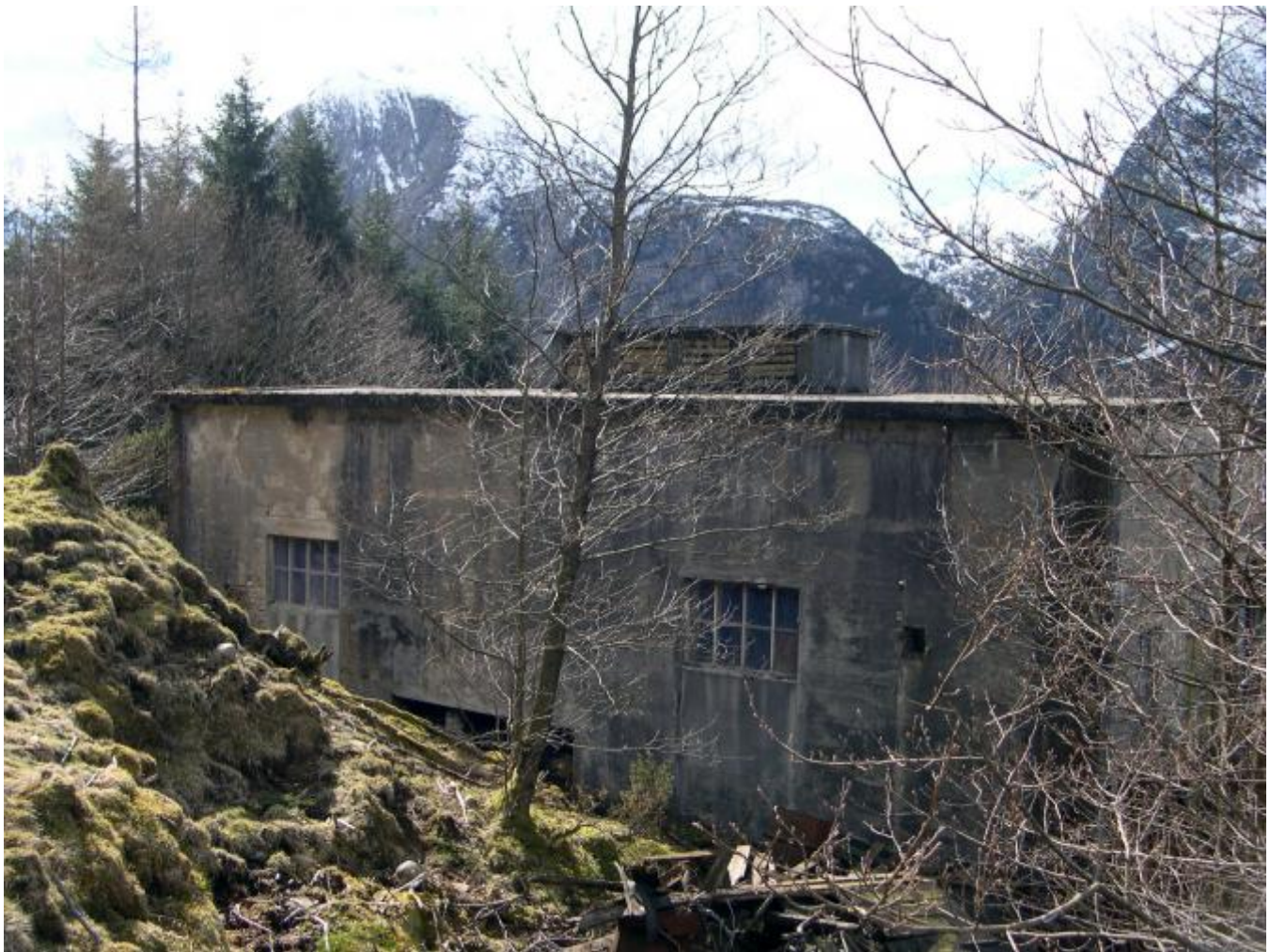
Kraftstasjonen i Tverrelva var i drift til på 1960-talet. (Foto: Ola Matti Mathisen)
