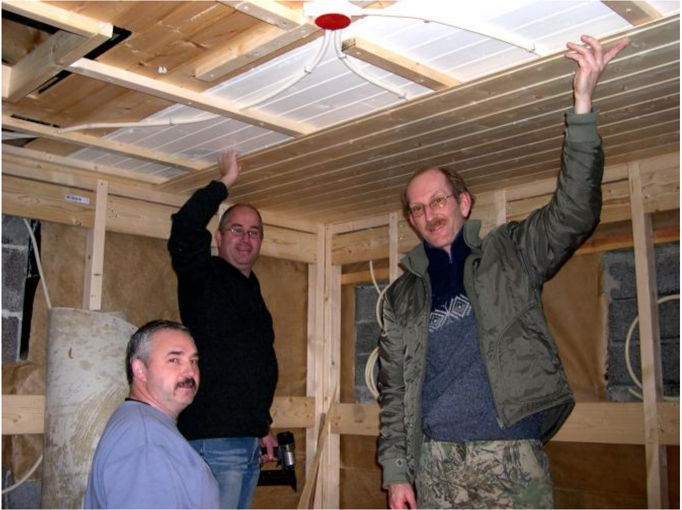
Klargjering for nytt kjøken i bedehuset: Tore Mathiesen, Jon Harald Kjærland og Jan Tvedt i arbeid. (Foto: Ola Matti Mathisen)
