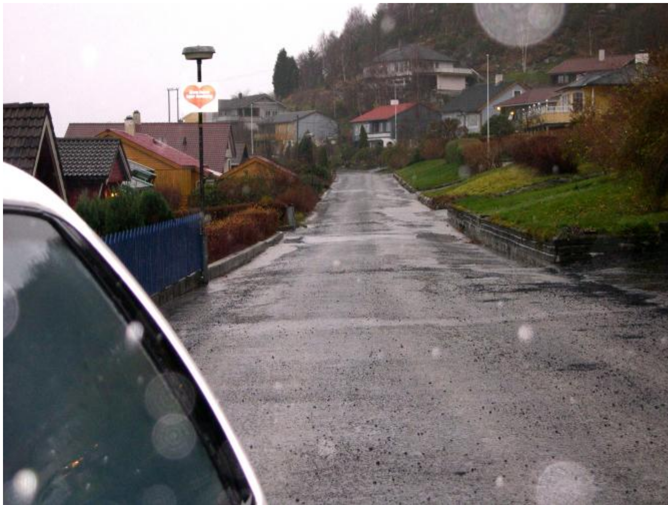
Den nedre gata i Halsabrotet blir ikkje nyasfaltert ferdig før i desember. (Foto: Ola Matti Mathisen)
