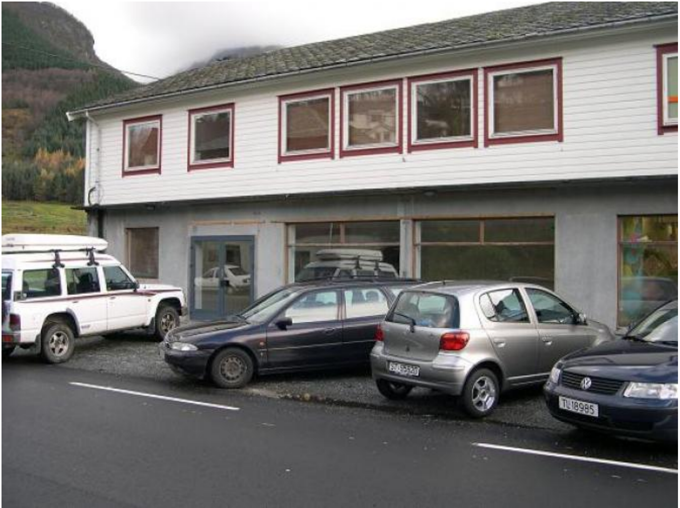
KIS er no i ferd med å koma på plass i det tidlegare samyrkelagsbygget
