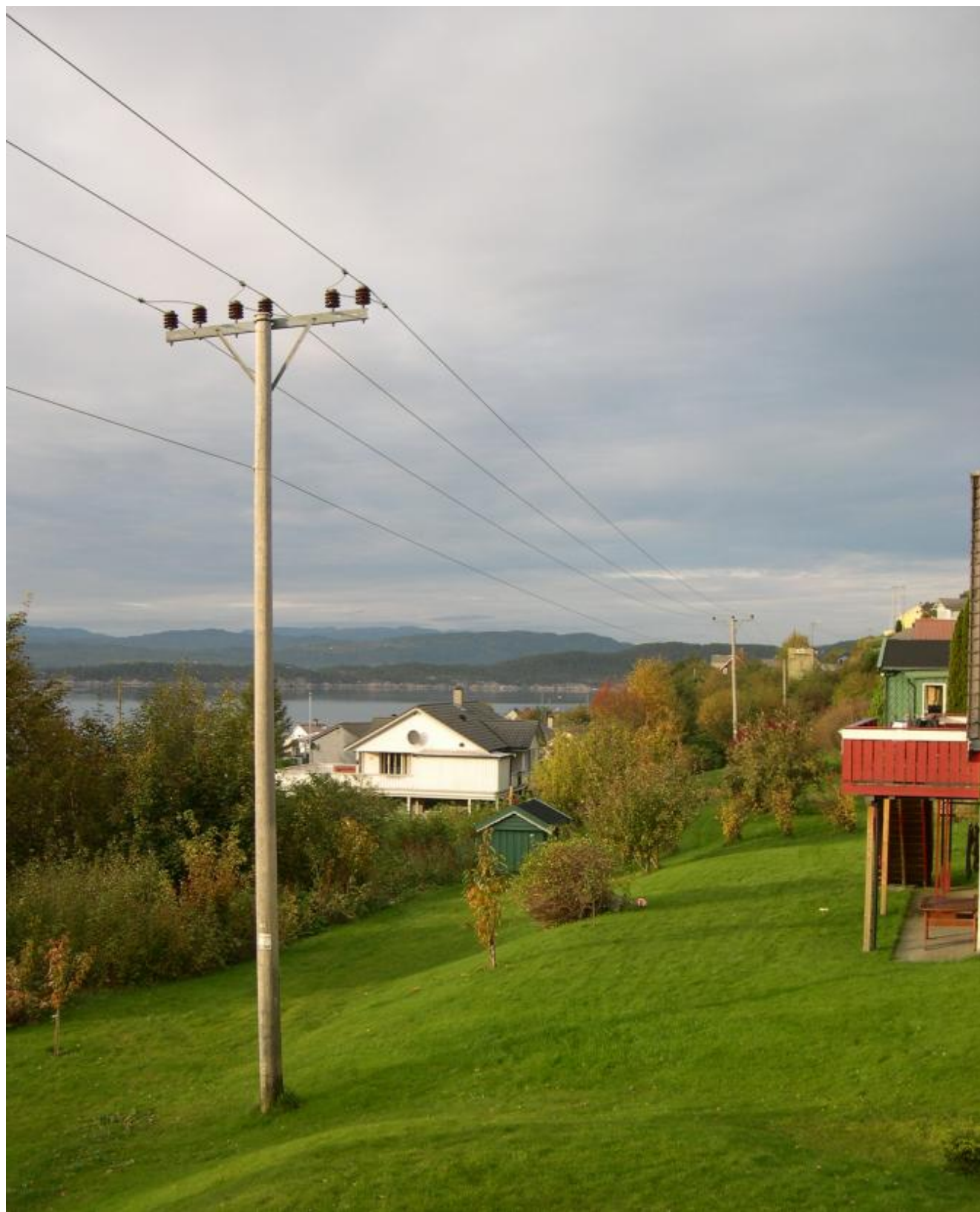
Høgspenlinja går gjennom både Halsabrotet og Skårhaug. Dette bildet er fra Halsabrotet. (Foto: Ola Matti Mathisen)
