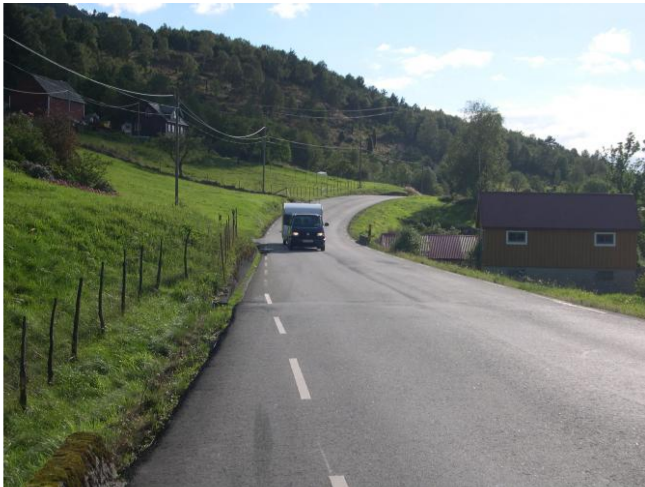
Her stansa asfalteringa i fjor – snart skal den halda fram mot Uskedalen. (Foto: Ola Matti Mathisen)
