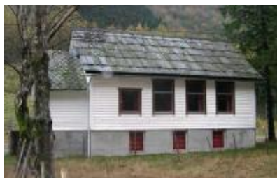
Vonheim er det vandrante huset. (Foto: Ola Matti Mathisen)
