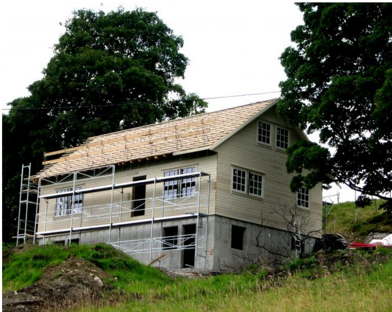
Byggjinga av Dønhaug Gardsbarnehage går raskt framover. (Foto: Ola Matti Mathisen)
