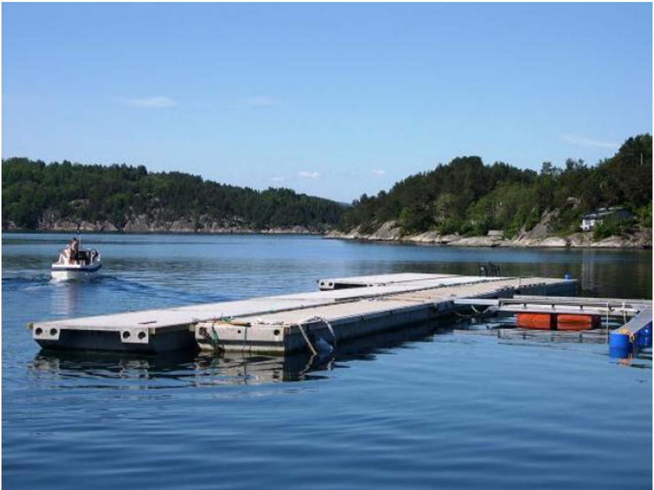
Dei nye bølgebrytarane, som i går ettermiddag låg klare utanfor dei gamle og skadde, skal monterast frå måndag morgon. (Foto: Ola Matti Mathisen)
