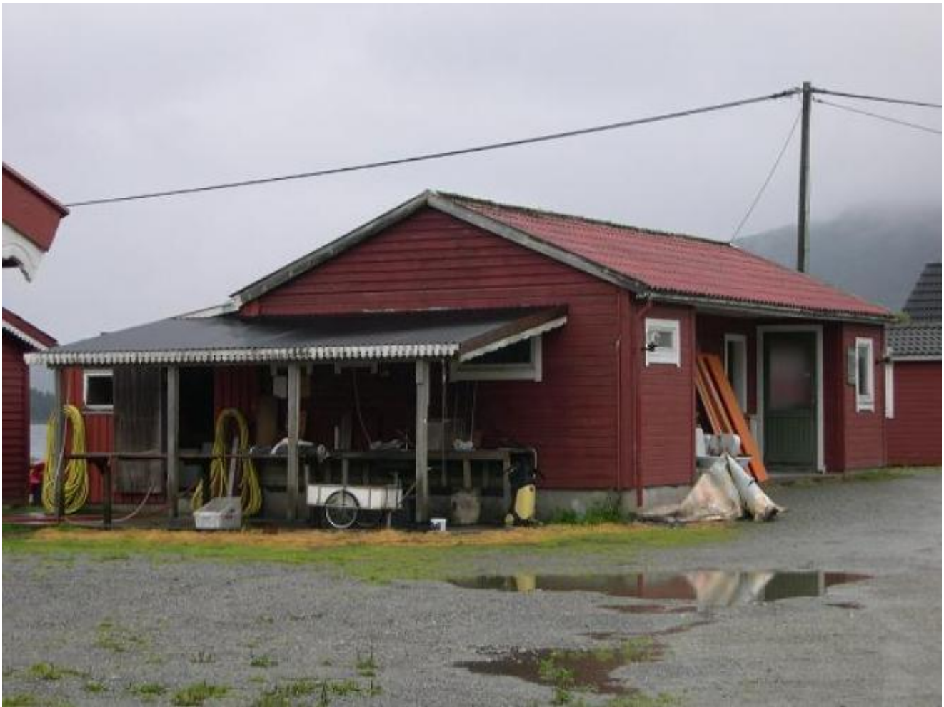
Sanitæranlegget kan oppgraderast utan ein ekstra etasje, meiner fylkesmannen. (Foto: Ola Matti Mathisen)
