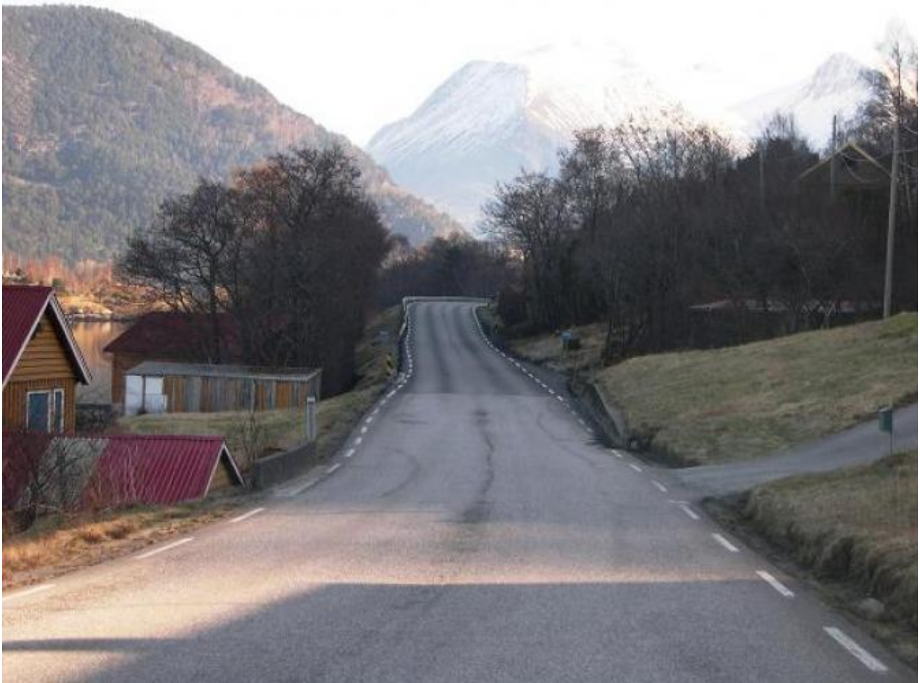
Den nye asfalten kom fram til Rød i fjor, no skal han først vidare til brua i Uskedalen. (Foto: Ola Matti Mathisen)
