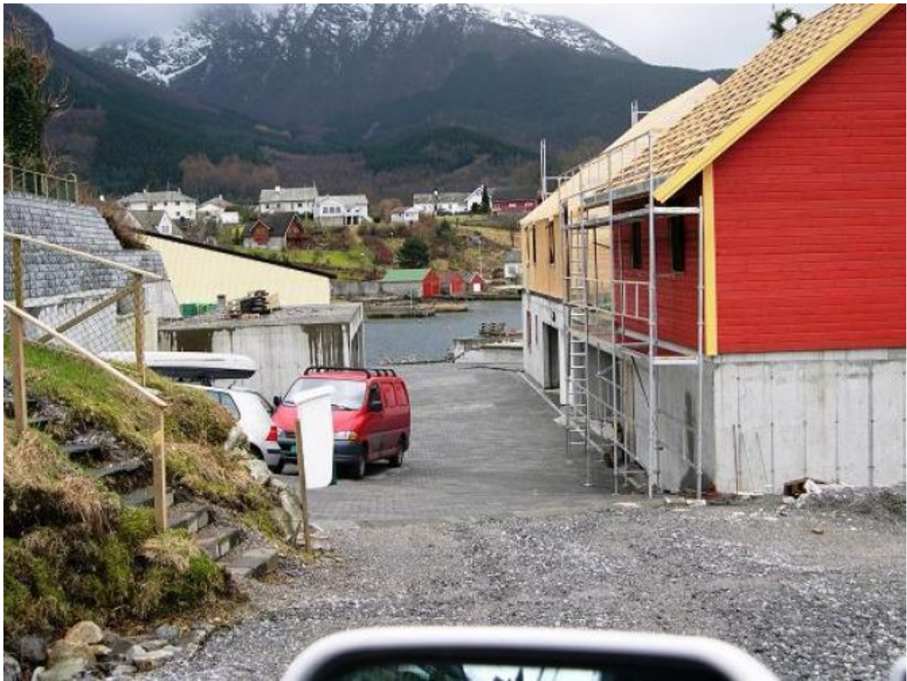
Her mellom garasjane kan det oppstå farlege situasjonar. (Foto: Ola Matti Mathisen)
