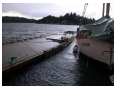
Elementa som som låg ytterst og var bølgebrytarar sto ikkje i mot stormen, som hadde orkan i kasta. Nå blir dei erstatta med kraftigare saker. (Foto: Ola Matti Mathisen)
