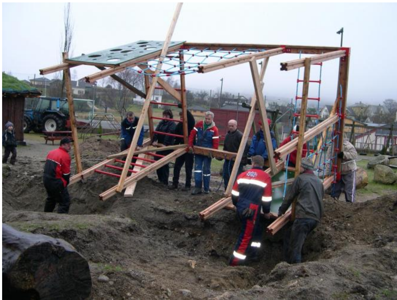
Felles løft for å få klatrestativet på plass. (Foto: Ola Matti Mathisen)
