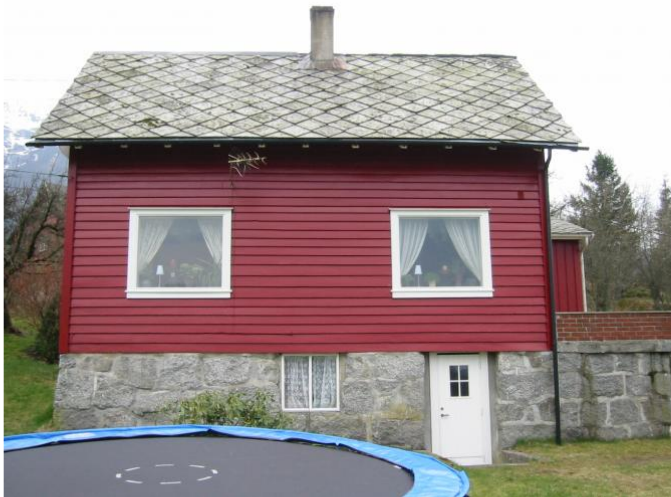
Skårhaug-bygningen slik han såg ut før restaureringa.
