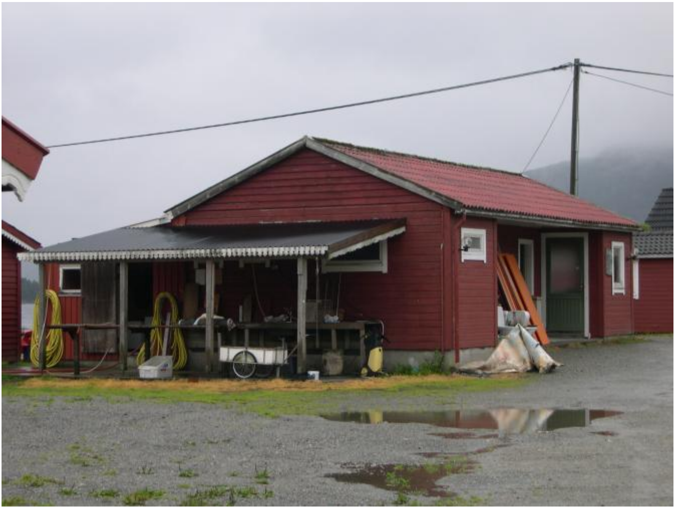
Får Rabben Camping lov til å vøla sanitærbygget trass i byggjeforbodet? Det skal forvaltningskomiteen ta stilling til i desembermøtet. (Foto: Ola Matti Mathisen)
