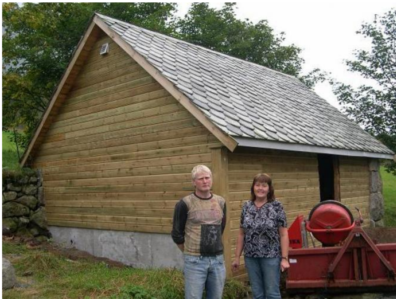
Det gamle eldhuset er no under restaurering og Kurt Eivind og Bjørg Inga har grunn til å vera særst nøgde med jobben så langt. (Foto: Ola Matti Mathisen)
