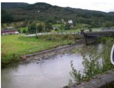
Ved riksvegbrua har det vore murararbeid i gang i det siste. (Foto: Ola Matti Mathisen)
