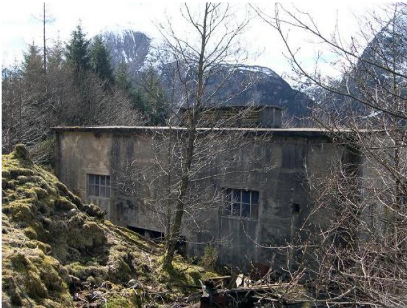
Dette er den gamle kraftstasjonen i Tverrelvo, som det ikkje blir aktuelt å renovera. (Foto. Ola Matti Mathisen)
