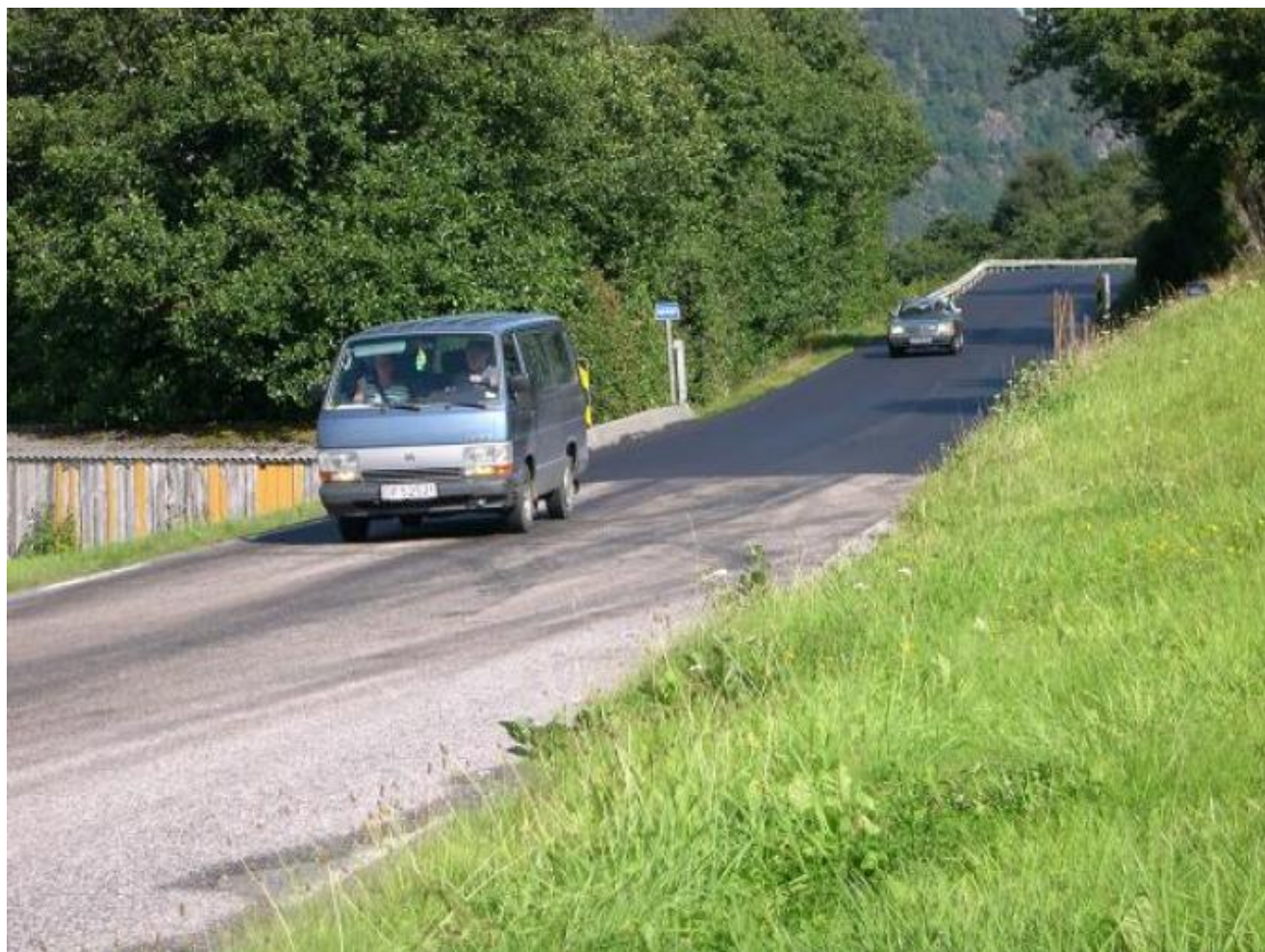
Ny asfalt er lagt på riksvegen mellom Dimmelsvik og Rød (biletet) dei siste vekene og denne veka kjem turen til kommunale vegar. Men ikkje til Uskedalen. (Foto: Ola Matti Mathisen).
