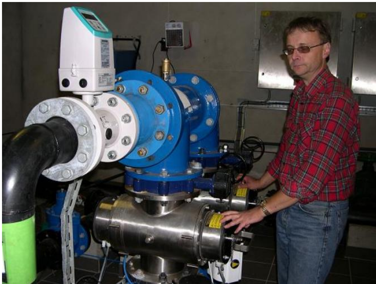
- Dette er anlegget for UV-behandling, forklarar formann Hans Reidar Kjærland. (Foto: Ola Matti Mathisen).
